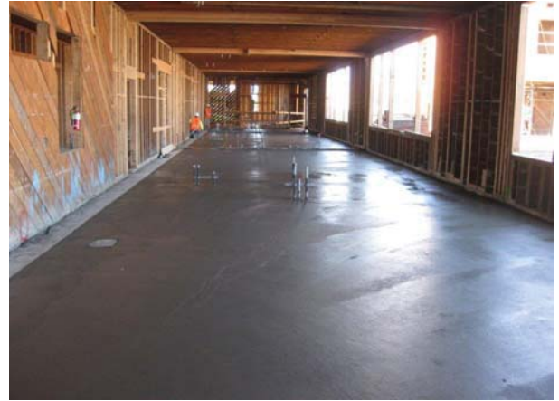
South Building - Concrete Pour
