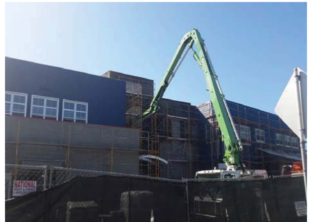
Building A - Second Floor Slab Pour
