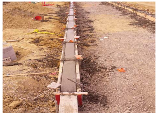
Concrete Pour of Perimeter track curb & trench drain
