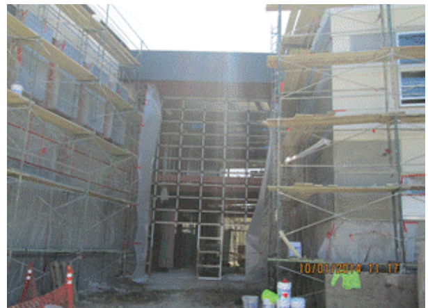
Site: Storefront window
