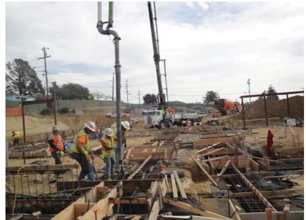
Building D - Footings Concrete Pour
