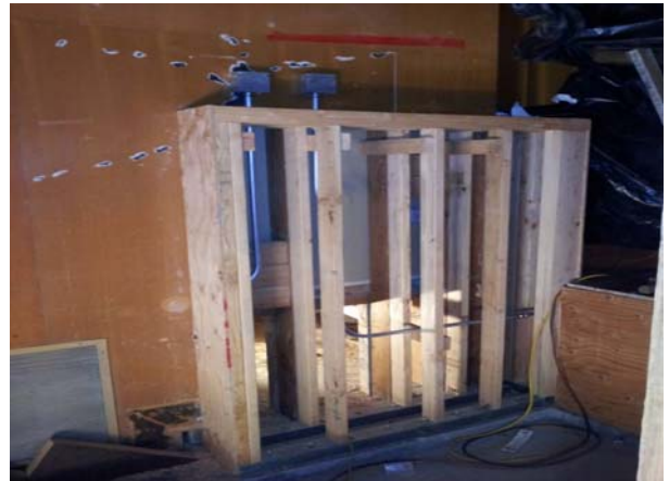
Multipurpose Room Conduit & Framing
