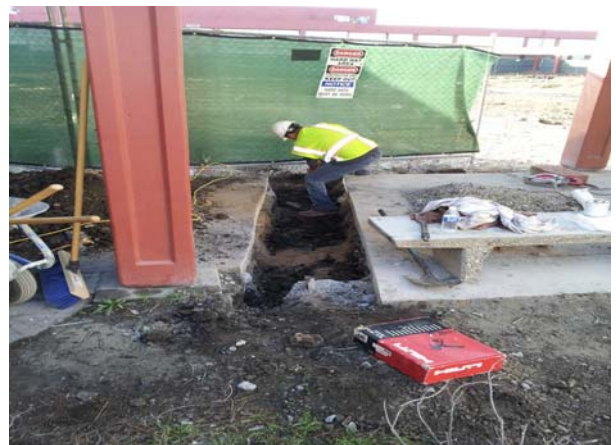
Install Electrical Conduit
