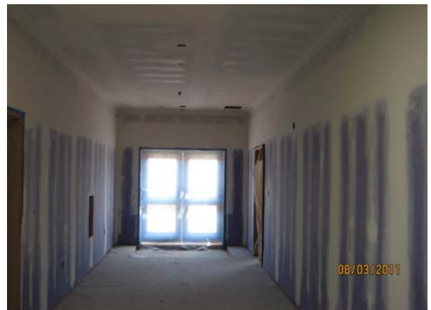
Door/Frame & Tape/Skim Drywall
