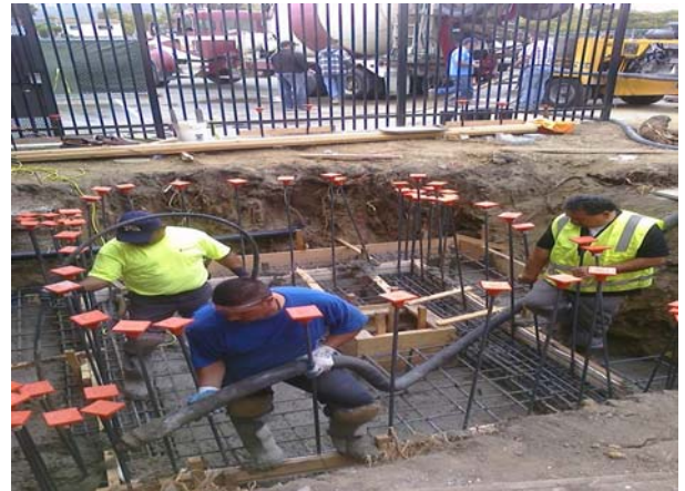
Concrete Pour at Elevator Pit
