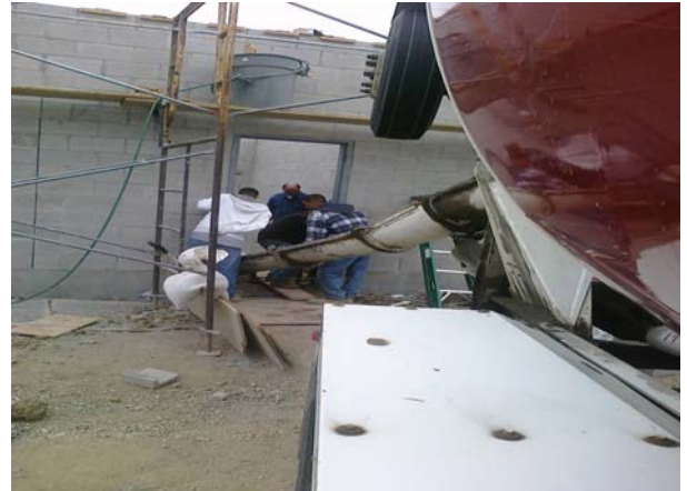
Concession Stand - Floor Slab Pour
