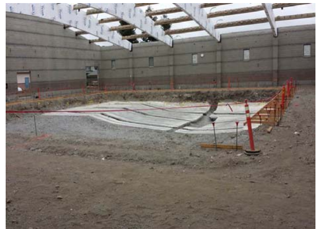
Main Pool - Edge Framing
