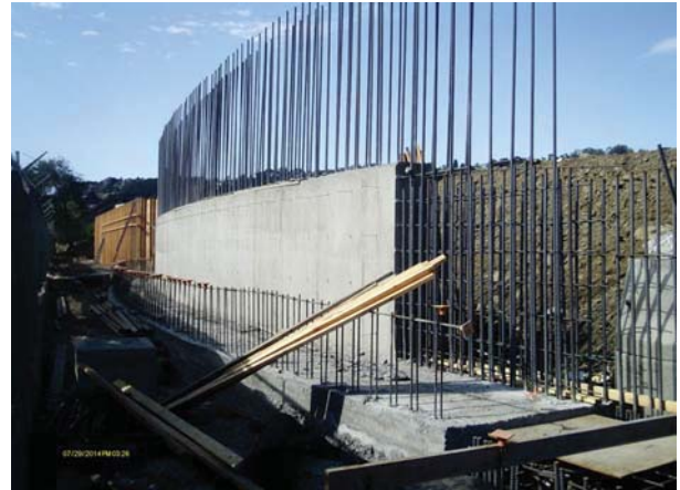
Ashbury retaining wall partial concrete pour
