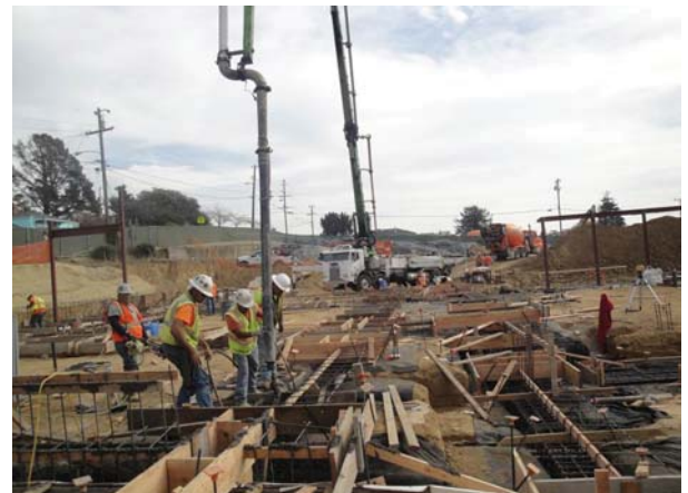
Building D - Footings Concrete Pour
