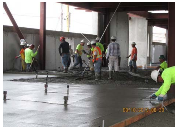
Building C - Slab on grade concrete pour
