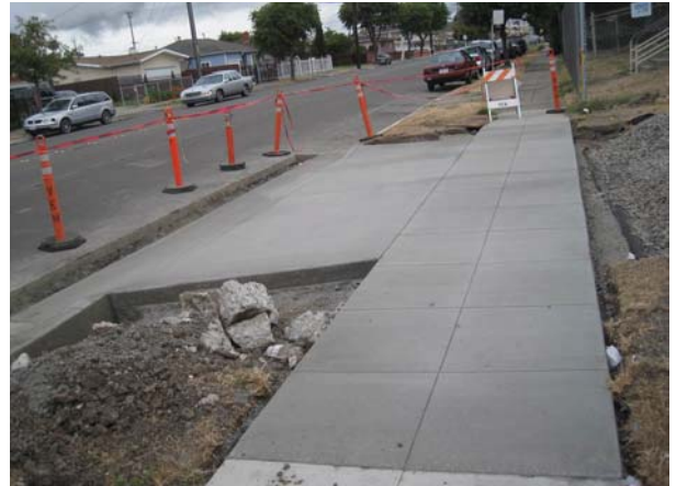
Main Construction Entrance Concrete Pour
