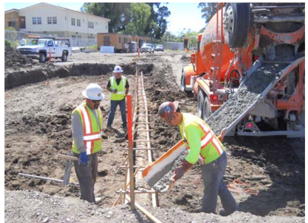
Concrete cap pour over storm drain pipe
