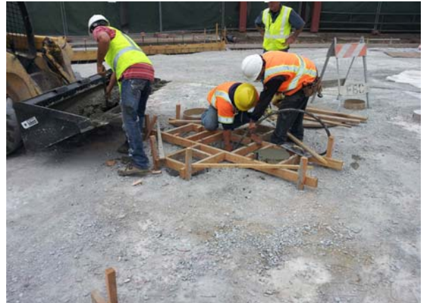
Concrete Pour for Tables and Benches
