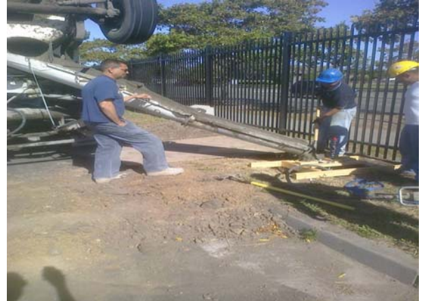
Concrete Pour for Light Poles
