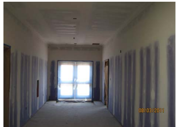
Door/Frame & Tape/Skim Drywall
