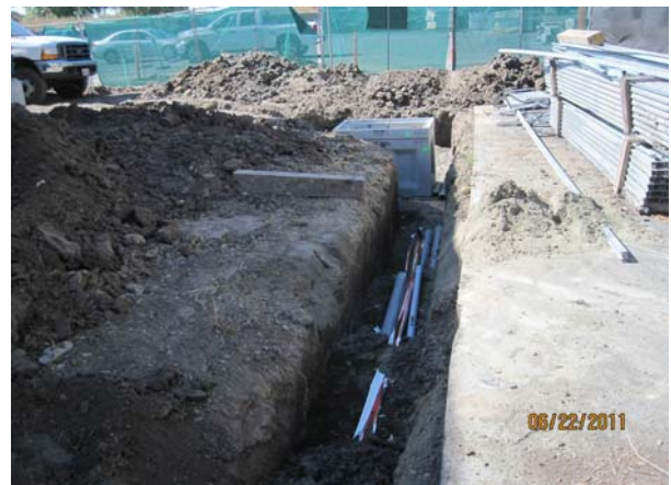
Underground Electrical Conduits
