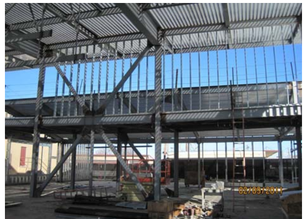
Exterior Steel Stud Framing
