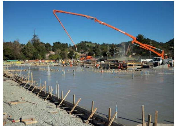
Building 2 Pour Slab on Grade
