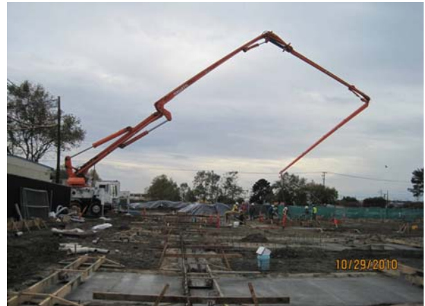
Footing Concrete Pour
