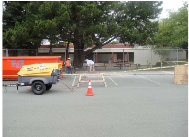
Concrete Pour - ADA Sidewalk
