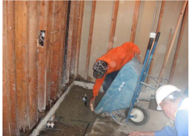
Concrete Pour - Administration Bathroom
