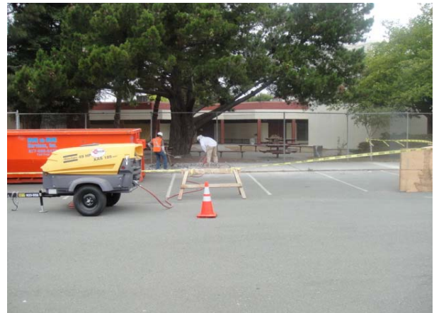
Concrete Pour - ADA Sidewalk
