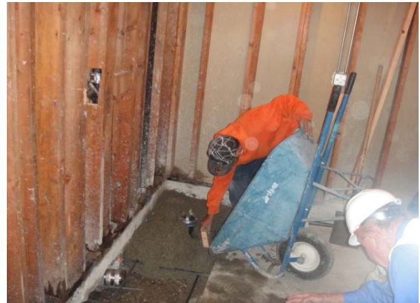
Concrete Pour - Administration Bathroom
