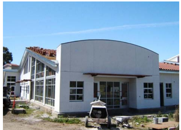
Building A: Ext. Stucco, Storefront & Windows
